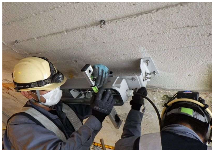
施工状況 (照明取付)
